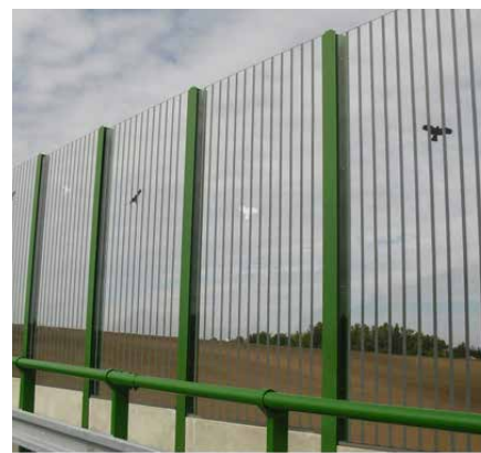
Tatáž stěna po zabezpečení
